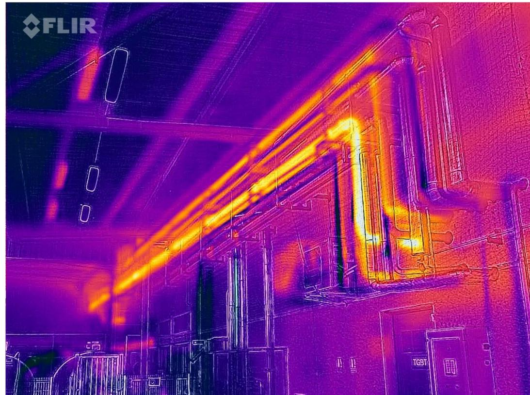
Absence de calorifugeage sur une conduite de vapeur à l'extérieur
